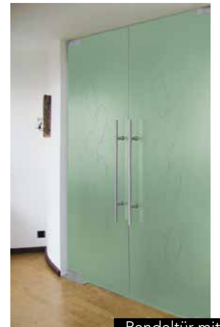
Pendeltür mit Bodentürschließer
