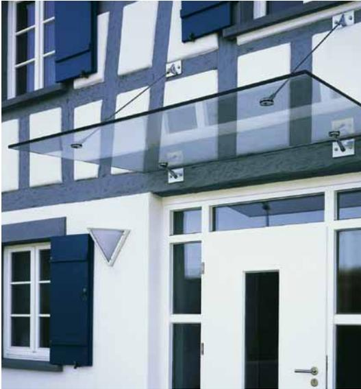
PUNKTGEHALTENES VORDACH MIT SPRI-POINT 70 AUS KLARGLAS. KONSOLEN UND ZUGSTÄBE AUS EDESTAHL.
