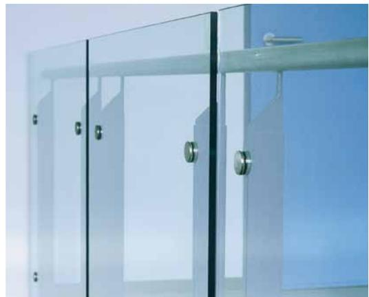
PUNKTFÖRMIG GEKLEMMTE VERGLASUNG MIT SEHR HOHEM SICHERHEITSANSPRUCH.
