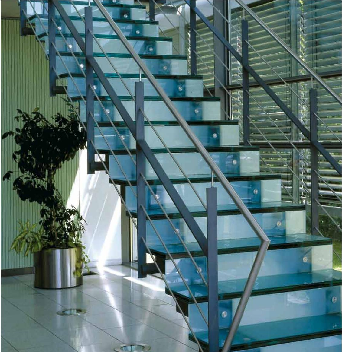
BEGEHBARES VERGLASUNGSSYSTEM MIT SETZSTUFEN IN VSG UND HELLMATTER FOLIE. INNOVATIVE BEFESTIGUNG MIT SENKSCHRAUBEN MIT SPRI-POINT 32M10. RUTSCHHEMMENDER KERAMISCHER SIEBDRUCK MIT PUNKTDEKOR FÜR TRITTSICHERHEIT.
