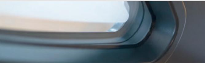
**Das Sicherheitsglas**, Fachsprache: durchwurfhemmendes Glas, besteht aus mehreren Scheiben, die mit einer reißfesten Zwischenschicht verbunden sind. Unsere Testpersonen durften 6 Minuten mit Hammer und Schraubendreher versuchen, eine handgroße Öffnung in das Glas zu schlagen. Fehlanzeige. Zusätzlich ist das Glas fest mit dem Rahmen verklebt, auch da ist kein Durchkommen.
