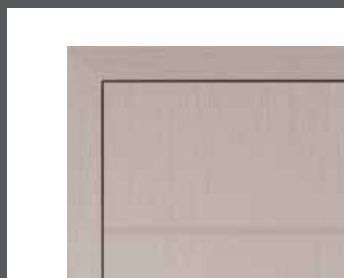
Furnier Art mit eingelegten Streifen in anderer Furnierichtung (aufrecht- und querfurniert)
