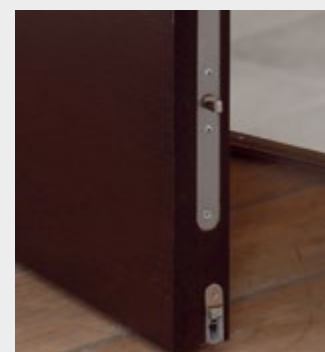
5-Punkt-Verriegelung mit Bodendichtung.
