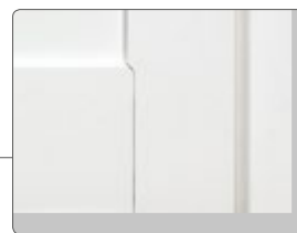
Zum Sockel abgeschrägt auslaufend mit Schattenfuge
